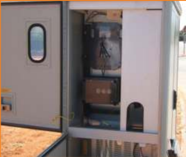
איור 2: דוגמת התקנה של ערכת חיבור מתועשת בתא ייעודי בתוך מרכזיית תקשורת
