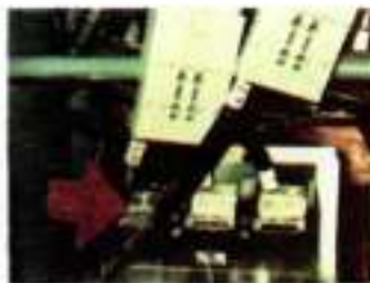
חיבורי כבלים ללוח - תמונה תרמית. המנוע השמאלי חם. טמפי הסביבה 30 מעלות צלזיוס. טמפי המנוע 107 מעלות
