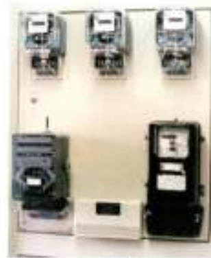
תמונה 4 מערכת מניה במתח נמוך הכוללת מונים תלת-פאזיים אקטיבי וריאקטיבי ושלושה מוני ביקורת
