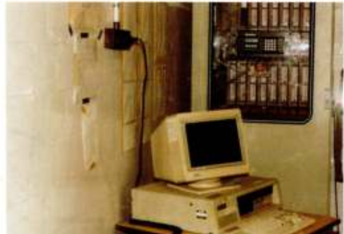
מערכת הבקרה הממוחשבת המפקחת על מערכת הקירור (המדחסים)
