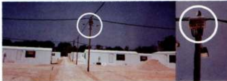
תמונה 2 רשת חלוקה פרטית לשכונת בתים יבילים המקבלת אספקה בצובר. בעינוול נראית תיבת ההסתעפות ממנה יוצא הכבל לחיבור הבית היביל
