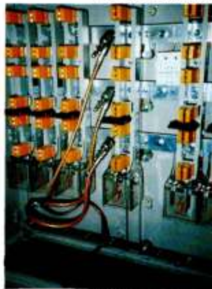
איור 3 מערכת מקצרים כדוריים המתקנת בלוח מתח נמוך
