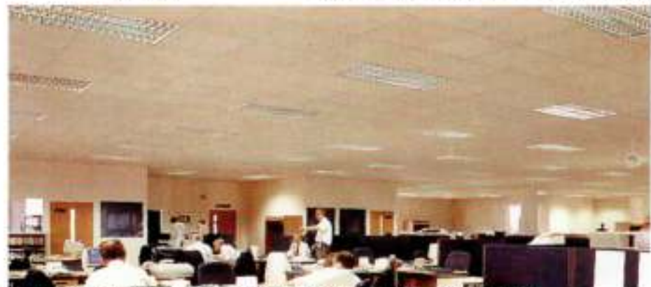
מערכת תאורה במשרד, המורכבת מגופי תאורה פלואורוניים עם מחזורי אור, מונעי סינוור.
