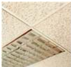
מערכת תאורה במשרד, המורכבת מגופי תאורה פלואורוניים עם מחזורי אור, מונעי סינוור.
