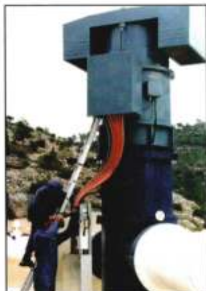
"תחת הלב" – מפעל הקו הרביעי לירושלים מנוע 2,500 כ"ס המחובר למשאבה
